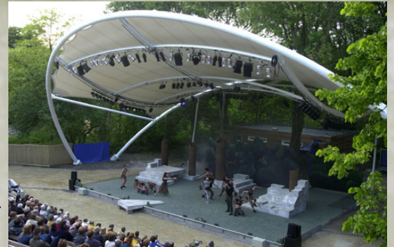
Overkapping Zuiderparktheater Den Haag
